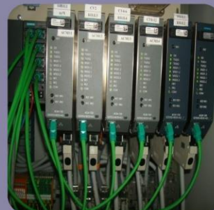
Компютри за системата за броячи на оси
