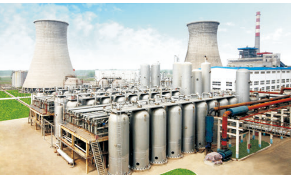
安徽昊源200000Nm 3 /h脱碳同时回收CO 2 装置
