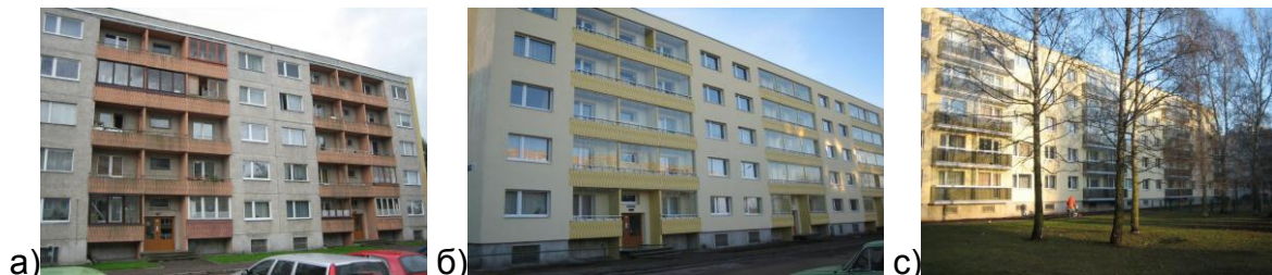
а) Главна фасада преди реконструкция; б),с) Фасади след саниране
