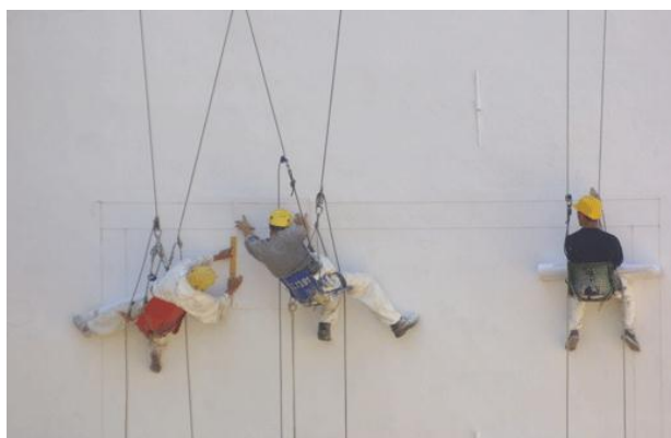
Поставяне на топлоизолация на фасадна стена.
