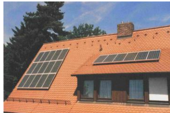
Двете групи модули са с различни наклони и различни видове- отделен инвертор за всяка част от групата или мултистрингов инвертор
