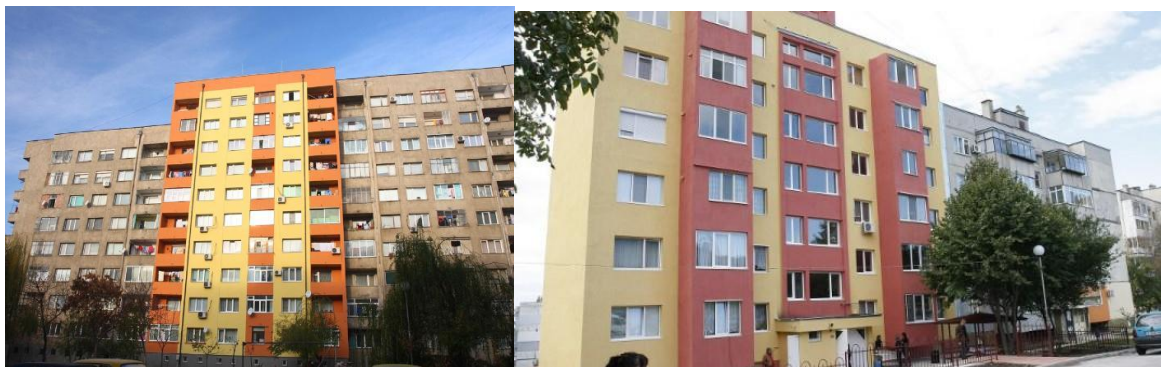
Санирана жилищна секция на панелна жилищна сграда.
