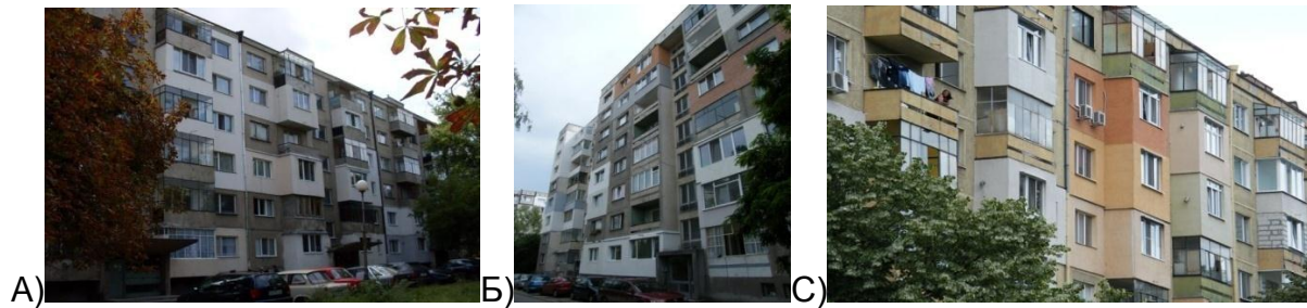
Индивидуално предприети ремонти в панелна жилищна сграда.
