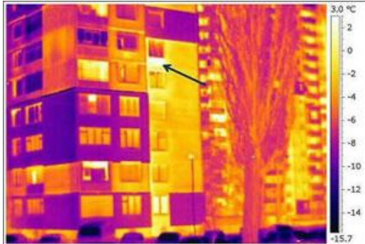
Термоснимка на панелна жилищна сграда
